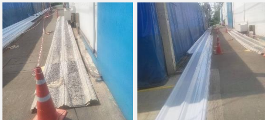
หลังคา Skylight ก่อนและหลังเปลี่ยน
